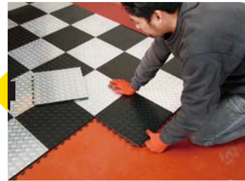
4. 1枚、1枚作業をすと確実ではあるが時間がかかるので不幸率。仲間がいれば横列で組み上げて、流れ作業で床材を組み上げていこう。
