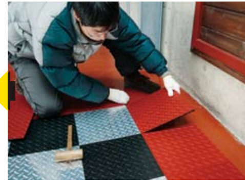
7. シルバーとブラックの床材を組み上げたところで、床面のまわりのレドを組み付ける。この床材を入れるだけで豪華な床面になる重要な部材。
