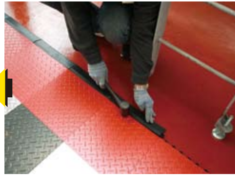
8. 床面が完成したらプラスチック製のエッジ部分を組み付ける。床面がならかになり、安全性が確保できる。
