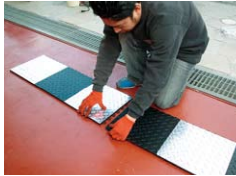
3. 床材の裏側を見れば分かるように、プラスチックでできたオスとメスを組んでいけば床面ができていく。まずは横列から組んでいくと作業がはかどるはず。
