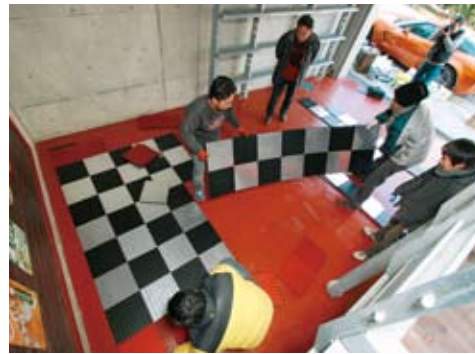
6. 究極の裏技は、広いガレージ外で横列を組み上げて、順番に組み合わせていく方法。この方法を編み出してからが作業時間1/2になった。
